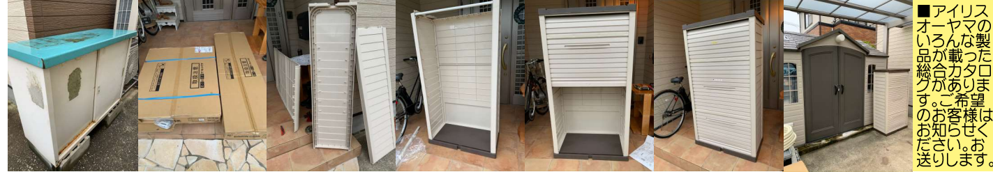
■古いロッカーです ■二つの梱包で入荷 ■背板と側板を組立 ■底板ねじ止め ■シャッターを取付け ■完成です! ■コストコ倉庫とお揃い
